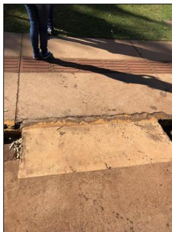
Figura. 9. Intersecção da calçada com a rua sem a devida marcação de piso tátil, 2019.
